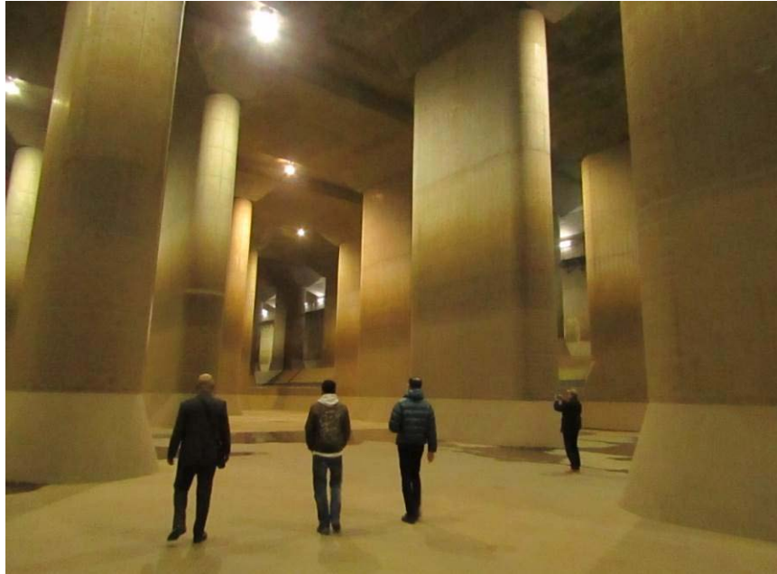
首都圏外郭放水路【地下神殿】(埼玉) 提供：宮内勝利会長
